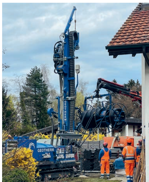
Beim Bohren der Erdsonden.
