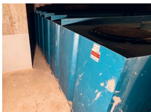
Vorher: Raum mit 20 000-Liter-Öltank.
