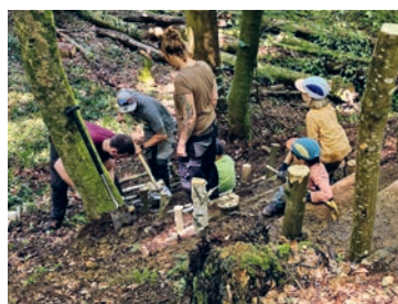
Eine neue Treppe für den Steigwald.
