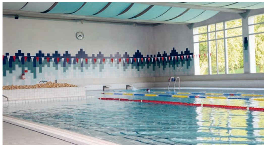
Die neue Technik und deren Steuerung sorgen für die perfekte Wasserqualität.
