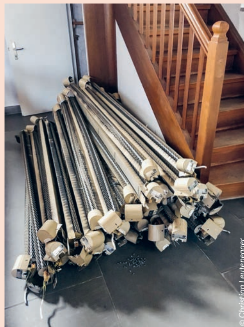
Die elektrischen Sitzheizungen sind demontiert.
