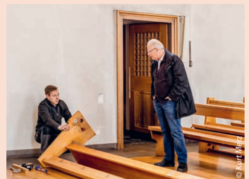
Die Kirchenbänke werden Stück für Stück abmontiert und teilweise eingelagert.
