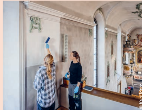
Versuche zur Wandrenovation fanden bereits statt.
