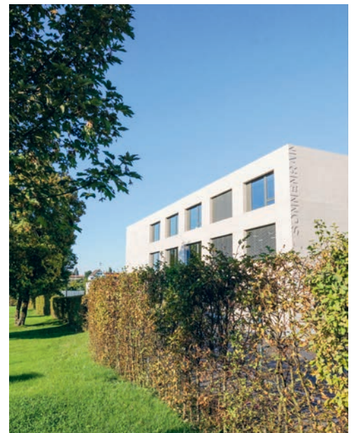
Während sich die Einen in der Badi vergnügen, bringen andere das Schulhaus von innen und aussen zum Glänzen.
