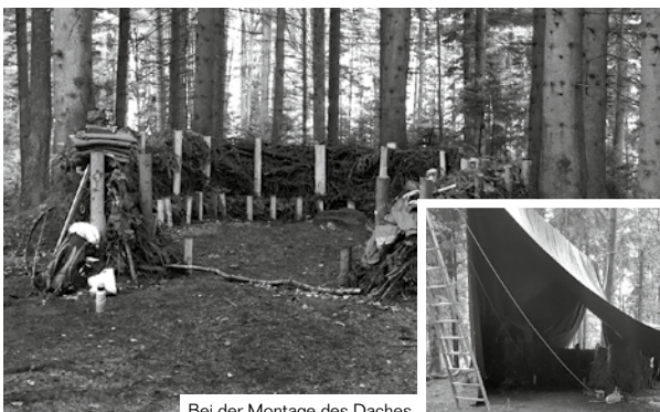
Bei der Montage des Daches.
